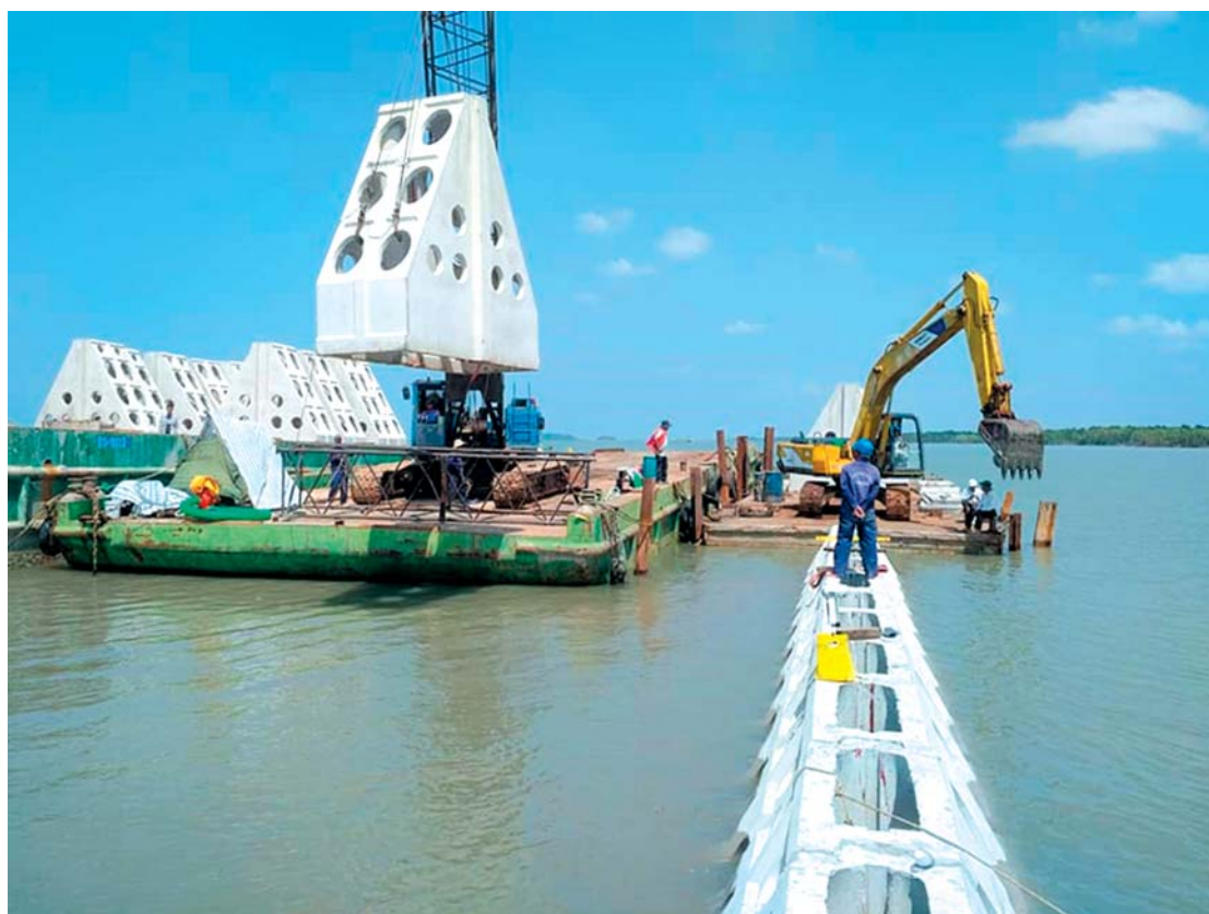
Thi công đê kè chắn sóng tại Cà Mau.
